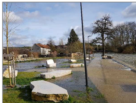
Place Marcel Noël, Mussy-sur-Seine, crue de janvier 2018
