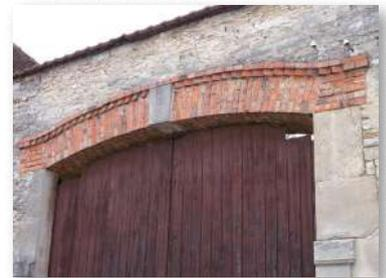
Linteau de brique avec clé et piédroit en pierre de taille, maçonnerie de moellons calcaire, Bossancourt
