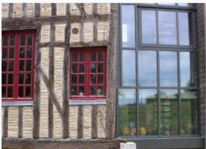
*Verrière à structure d'aluminium laqué, transition entre une construction ancienne en pan de bois et une extension contemporaine, Courteranges*
