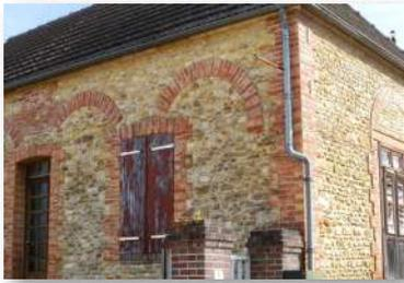
Moellons calcaires à jointoiement en creux, chaînages et encadrements en brique saillants indiquant qu'un enduit était probablement prévu, Briel-sur-Barse
