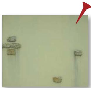
Ne pas chercher à évoquer un enduit traditionnel à pierre vue sur moellons en utilisant des pierres apparentes en décor sur un enduit monocouche : outre l'aspect anecdotique, les pierres occasionnent rapidement des coulées grises disgracieuses.
