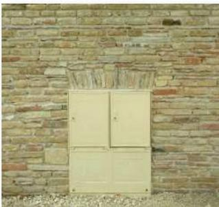
Coffrets parfaitement intégrés dans une maçonnerie de brique incluant un détail soigné (arc de décharge)
