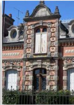
Trois matériaux seulement, utilisés dans une infinie variété d'assemblages : la brique de couleurs variées, le moellon calcaire, les blocs de craie taillés
