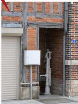
*Coffret électrique installé sans souci du bâti (comme le volet roulant !)*
