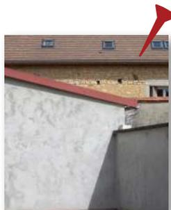
L'enduit ciment est à proscrire sur un mur ancien! S'il existe et si les parois présentent de l'humidité, il est nécessaire de piquer le supprimer et refaire un enduit à la chaux.
