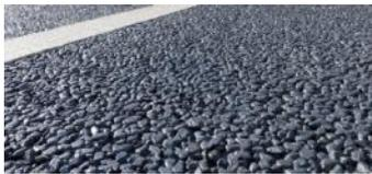
Revêtement superficiel en béton perméable
