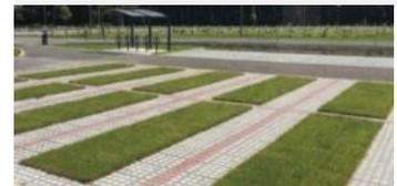
Combinaison de bandes en dalles végétalisées et en dalles pavées pour les roues des véhicules
